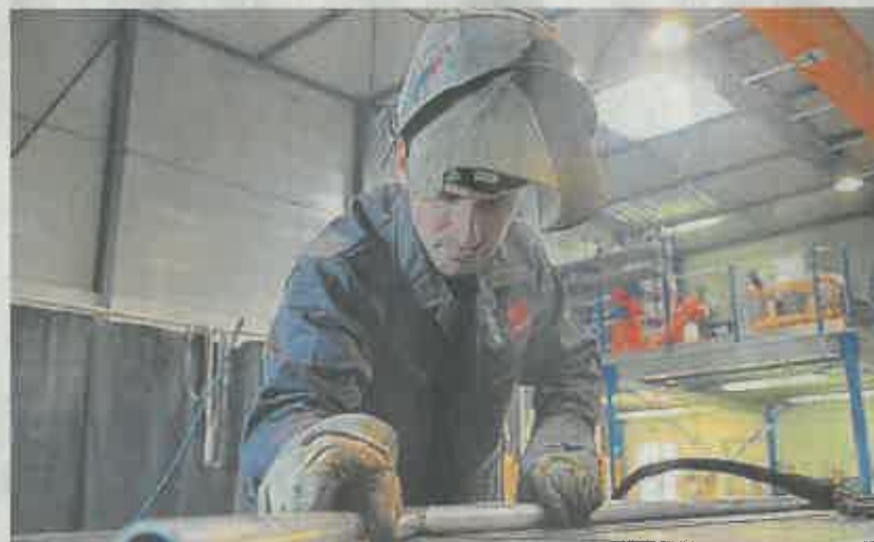
Comme Raphaël ici à la soudure, ils sont entre dix et quinze salariés à œuvrer au sein de l'atelier et à l'installation sur site des équipements.
